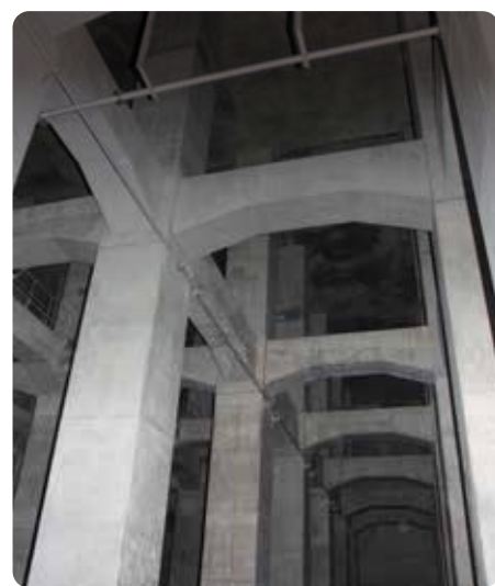
「完成した善福寺川地下調節池」
