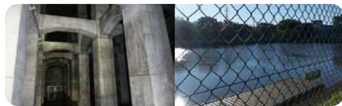
善福寺川地下の調節池(左)と平常時は野球場の和田堀第6調節池(右)
